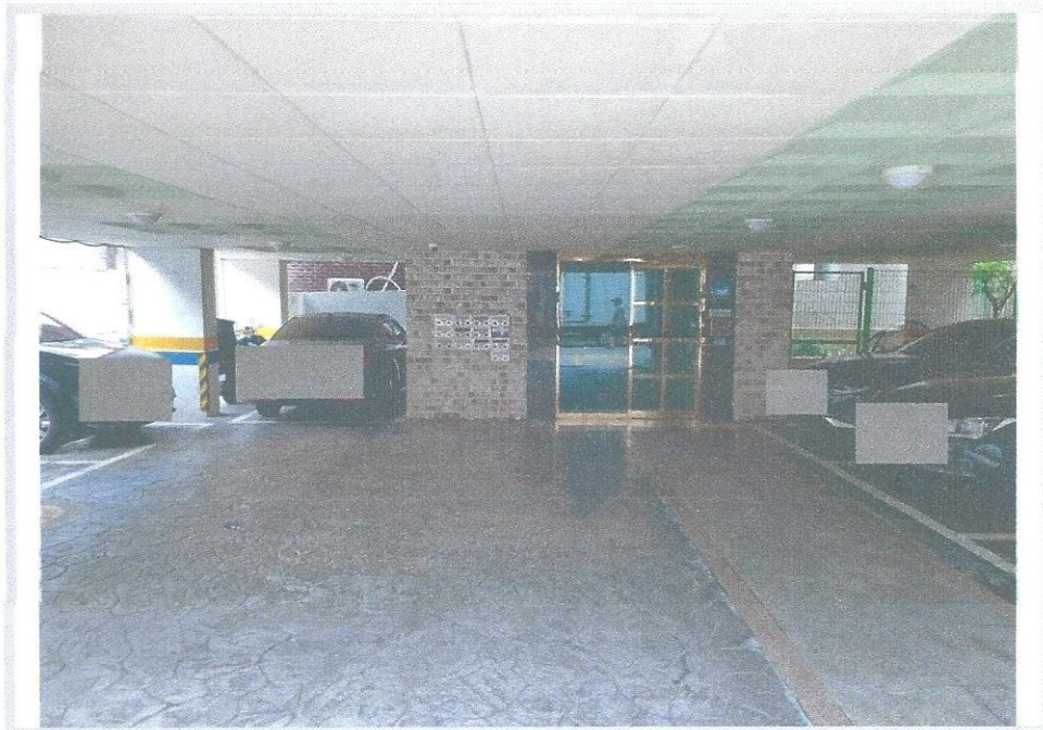
제1층(주차장 및 외부출입문)
