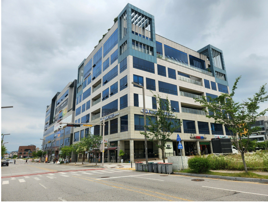
본건 소재 건물 전경(북서측 촬영)
