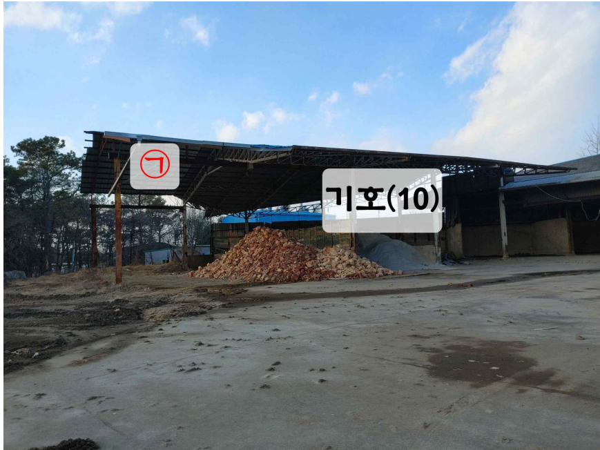
기호(10), 제시외건물(7) 전경
