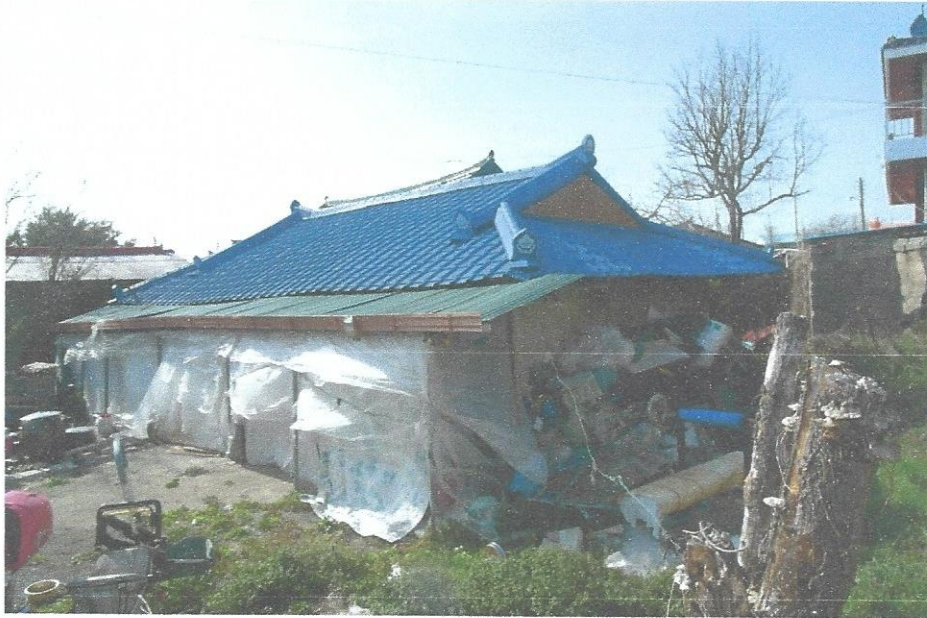
본건 토지 및 제시외 건물 및 수목
