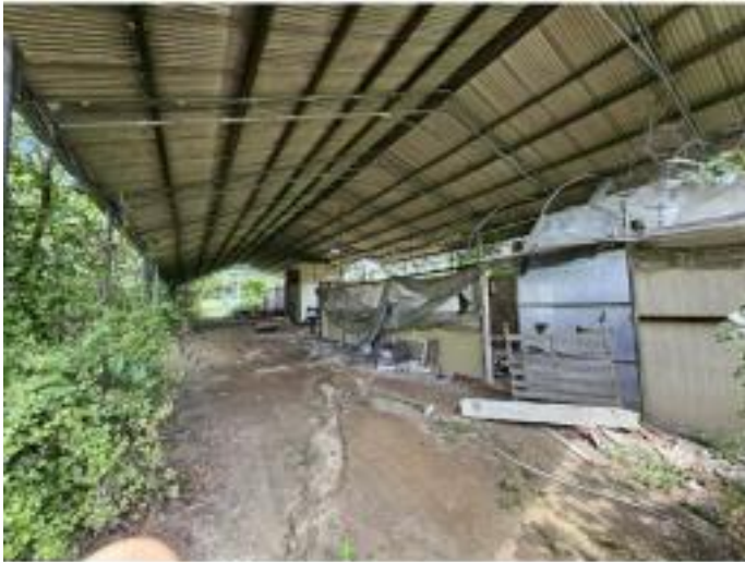
기호(2-4) 건물 내부전경1
