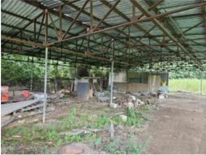
기호(2-3) 건물 내부전경1
