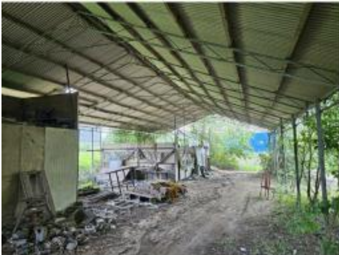
기호(2-4) 건물 내부전경2
