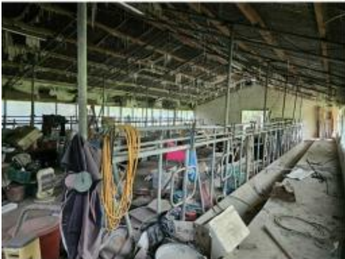
기호(2-1) 건물 내부전경1
