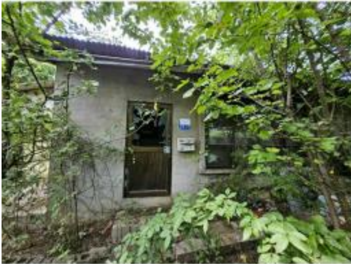
기호(2-2) 건물 외부전경1
