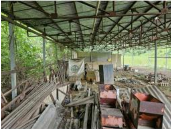
기호(2-3) 건물 내부전경2
