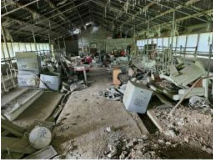
기호(2-1) 건물 내부전경2
