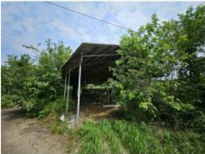
기호(2-4) 건물 외부전경1
