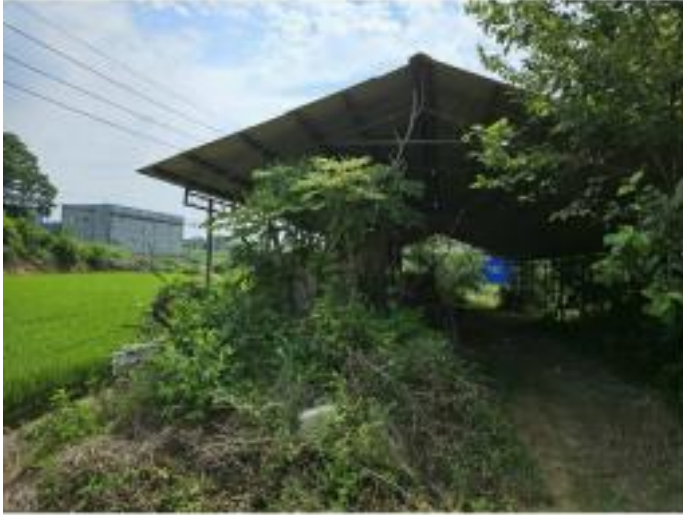
기호(2-4) 건물 외부전경2
