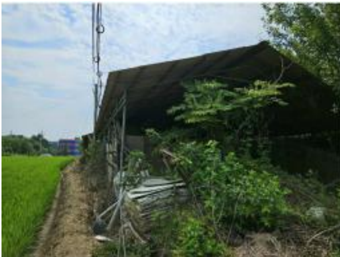
기호(2-3) 건물 외부전경2
