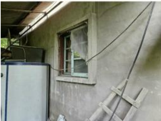
기호(2-2) 건물 외부전경2
