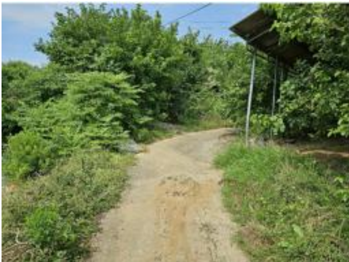
본건 토지중 현황 "도로"부분 전경
