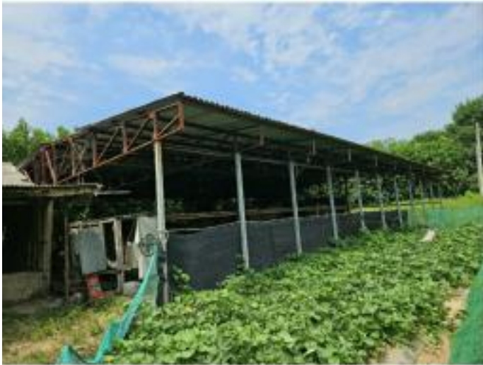
기호(2-3) 건물 외부전경1
