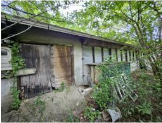
기호(2-1) 건물 외부전경1
