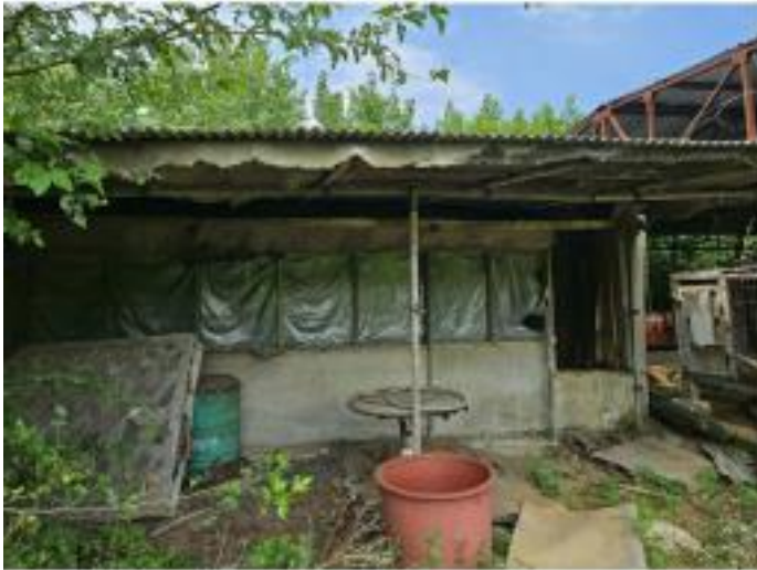
기호(2-1) 건물 외부전경2
