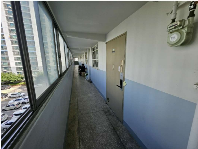
본건 5층 복도실 전경
