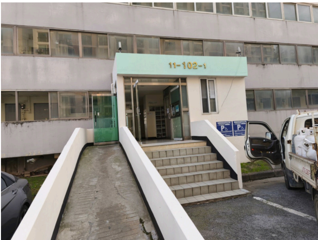
본건 1층 출입구
