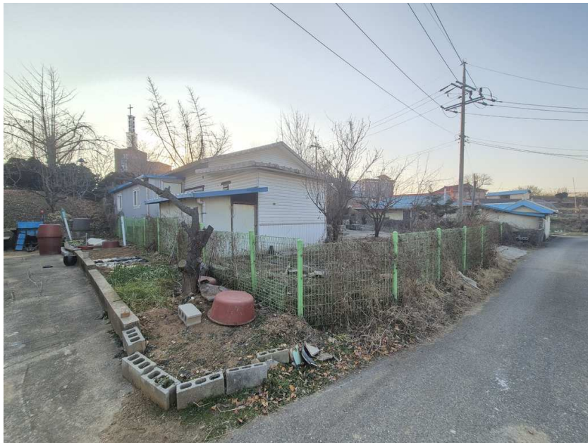
본건 전경(북서측에서 촬영)
