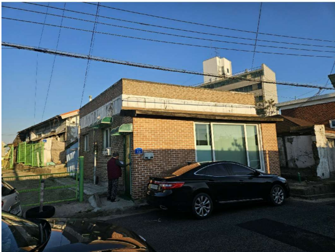
기호(2) 건물 외부전경(전면)
