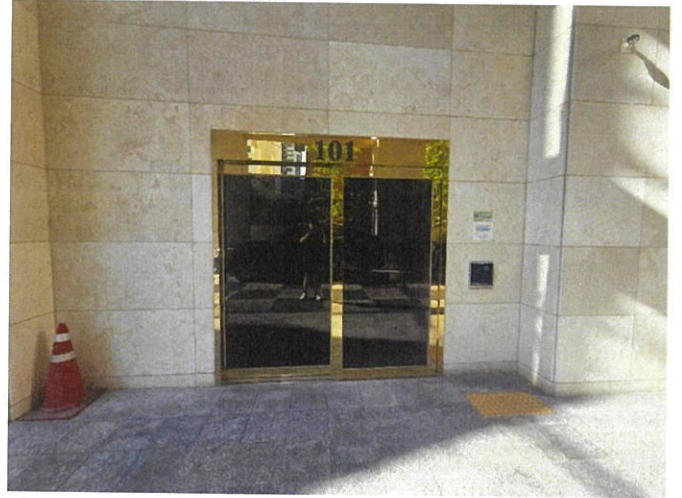
본건 1층 출입문
