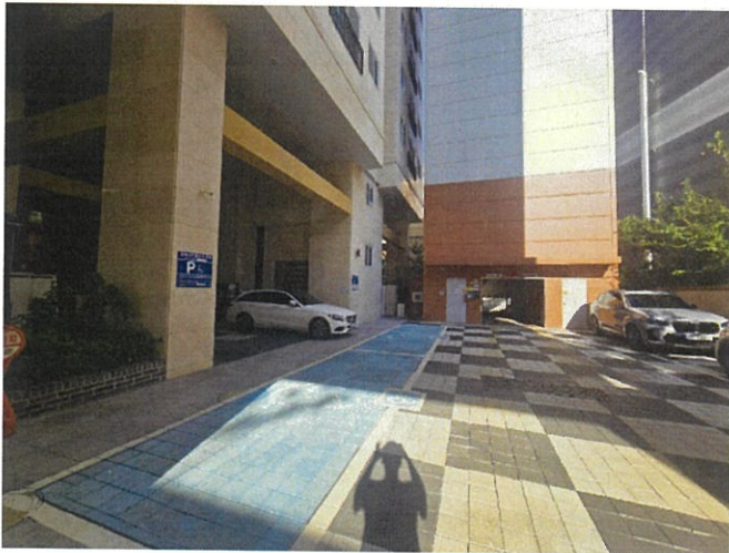
본건 지상주차장(자주식 및 기계식)
