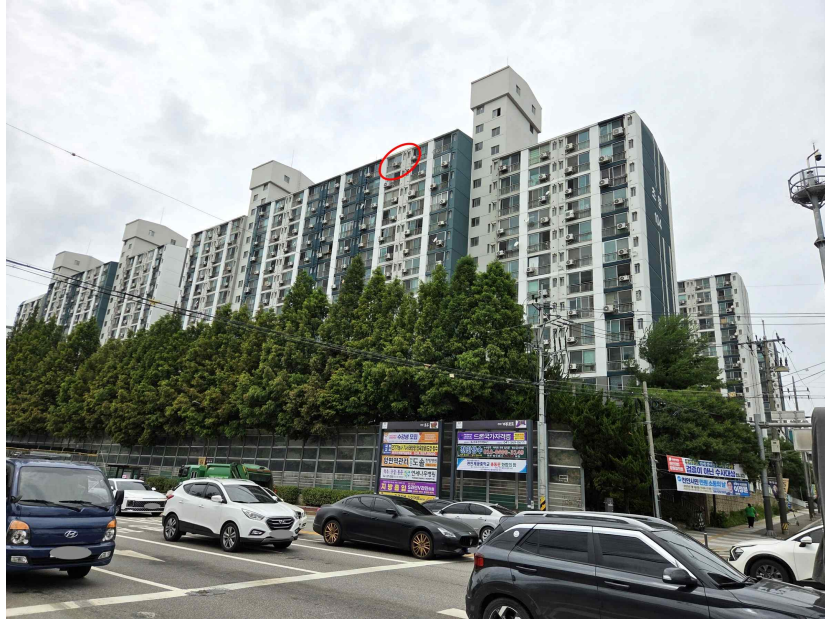
본건 전경(남동측에서 촬영)
