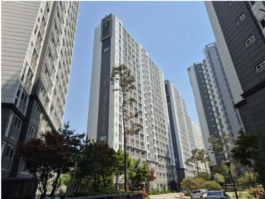
1동 건물의 전경
