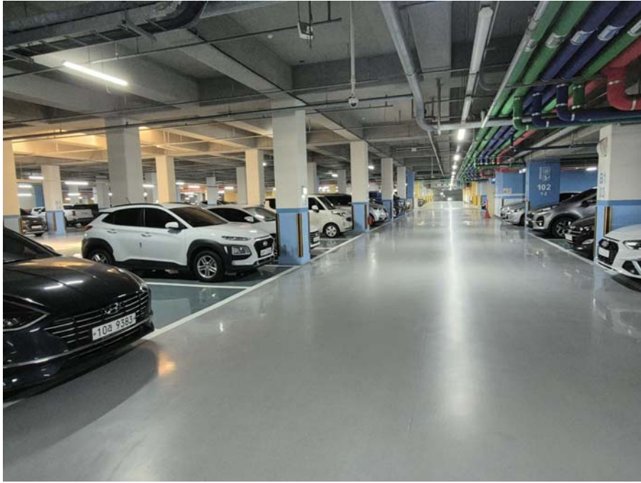
지하 주차장 전경
