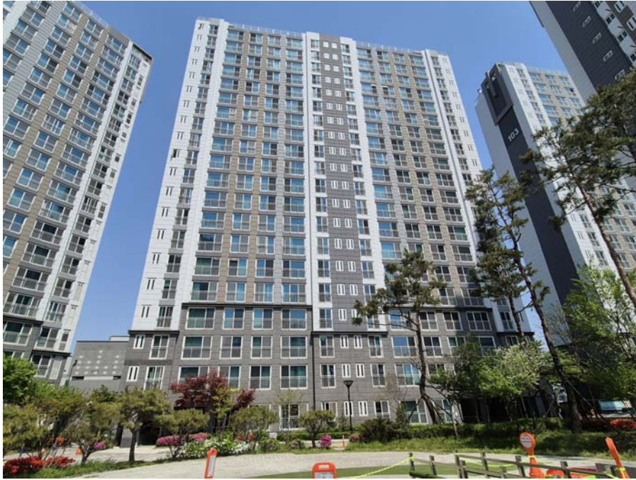
1동 건물의 전경
