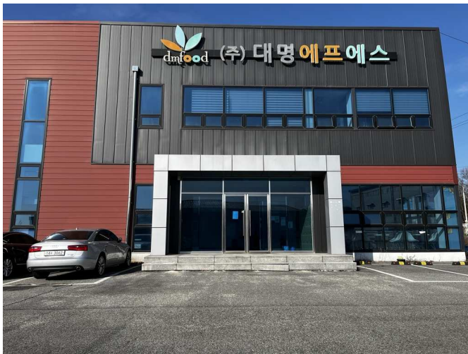
기호2 건물 전경
