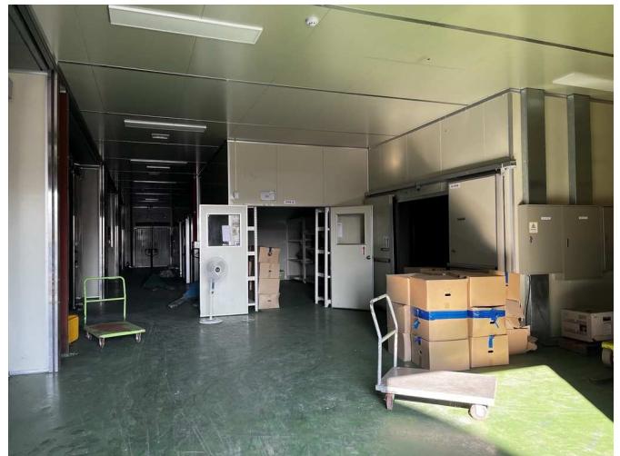
기호2 건물 1층 내부
