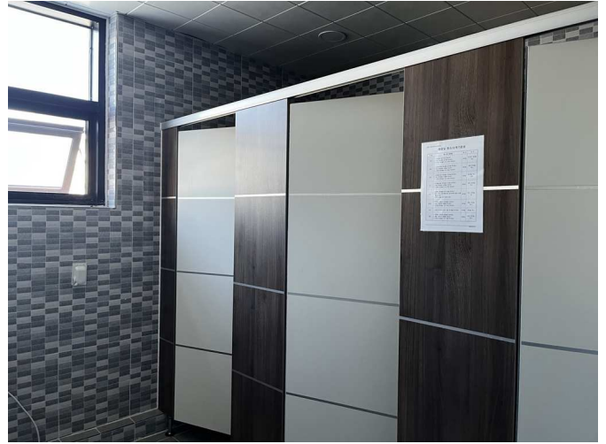
기호2 건물 2층 화장실
