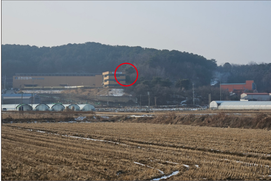
대상물건 및 주변환경(북동측 촬영)
