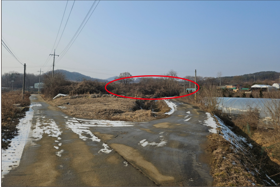
대상물건 및 주변환경(북동측 촬영)
