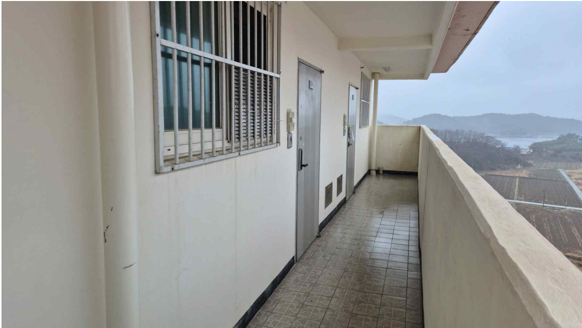
[ 본건 전경: 기호 ⑦ ]
