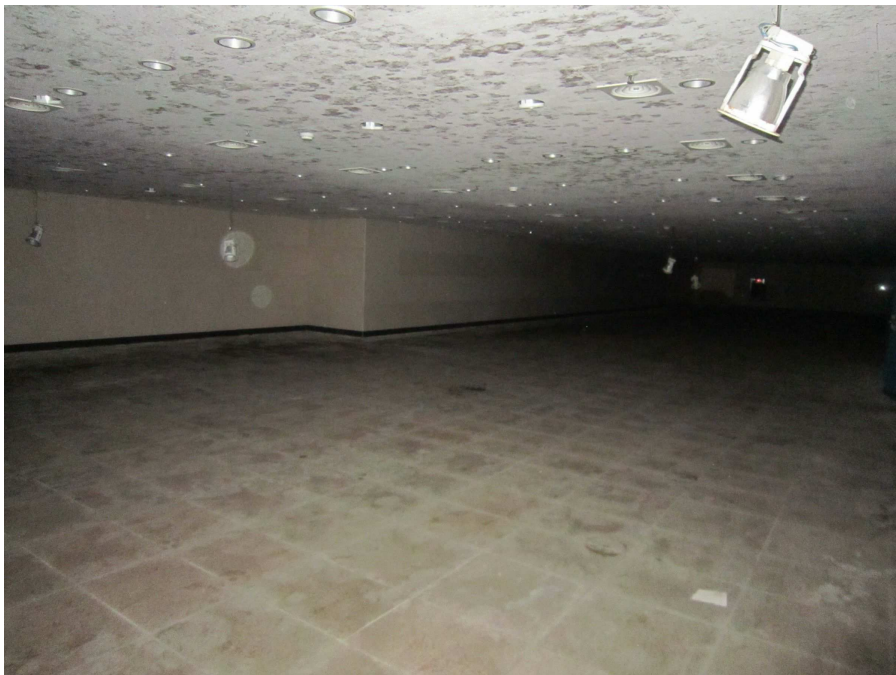
본건 기호 1 건물 지하1층
