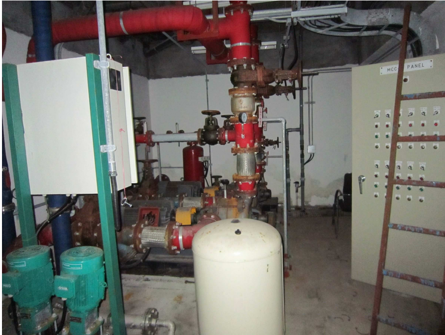
본건 기호 1 건물 지하1층
