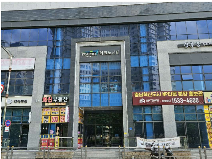
본건 1층 공동출입구 전경(북측 입구)
