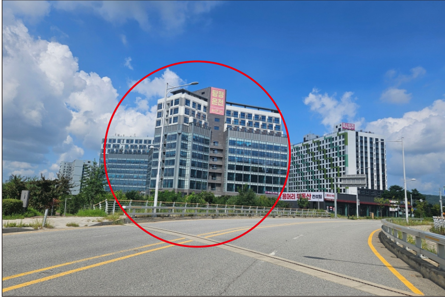
대상물건 주변환경(남동측 촬영)
