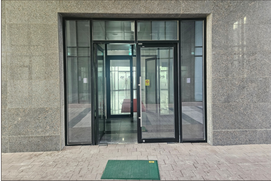
대상물건 전경(1층 출입구)
