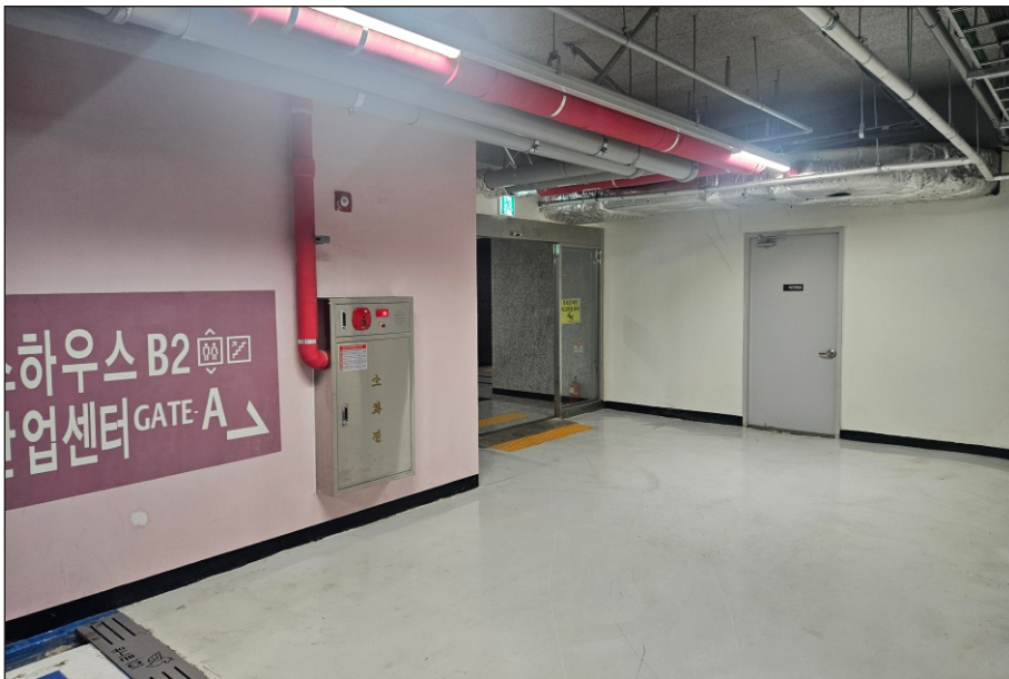
대상물건 전경(지하층 출입구)
