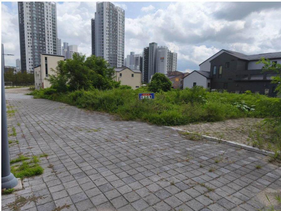
본건 전경(북서측에서 촬영)
