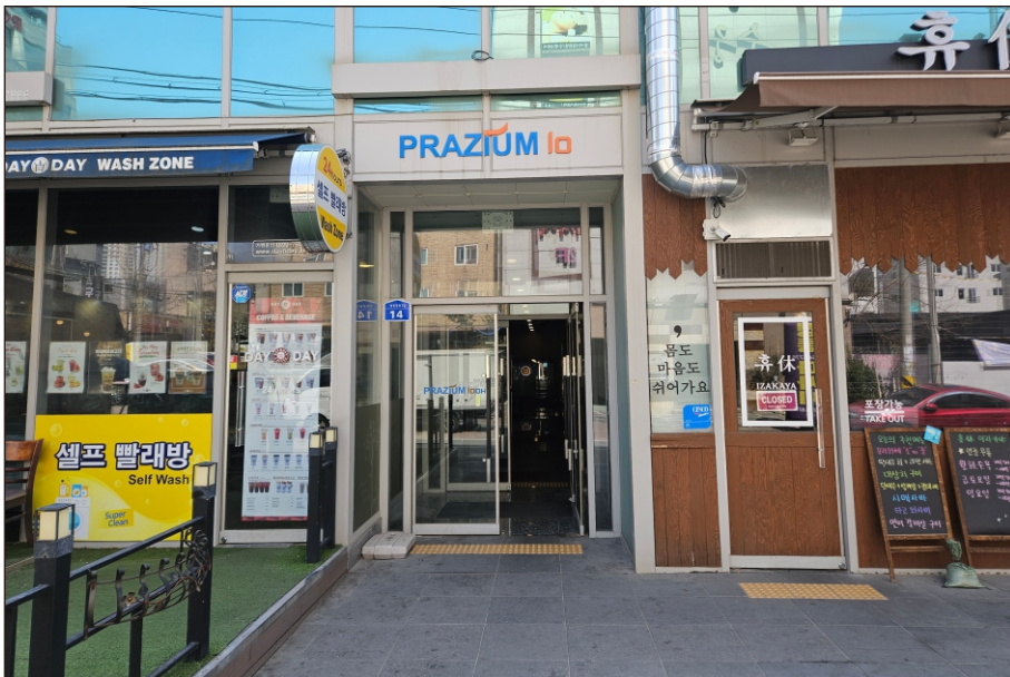
대상물건 전경(1층 출입구)
