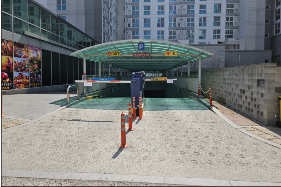
대상물건 전경(주차장 출입구)
