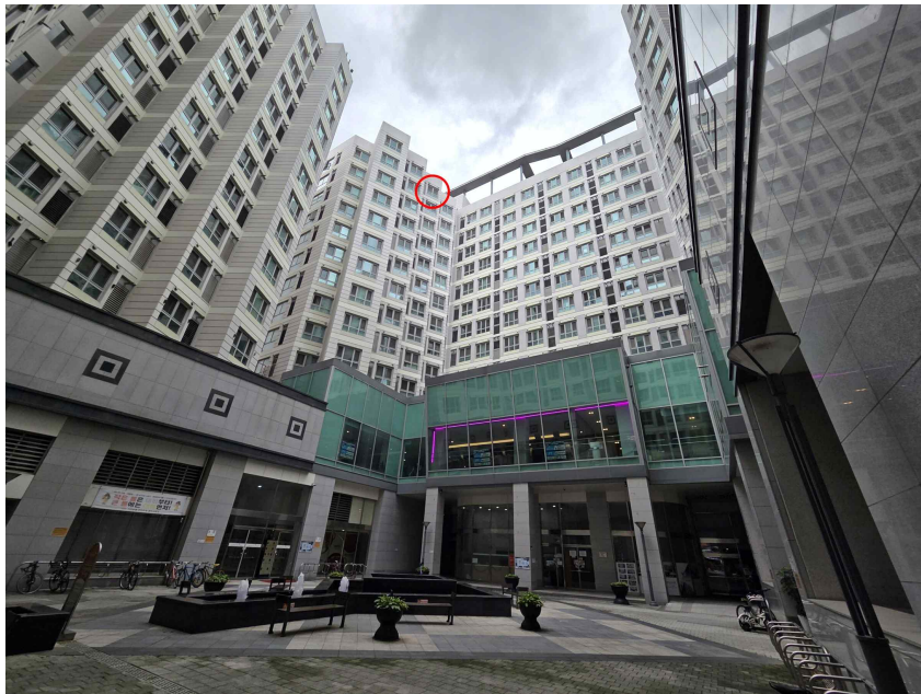
본건 전경(남동측에서 촬영)
