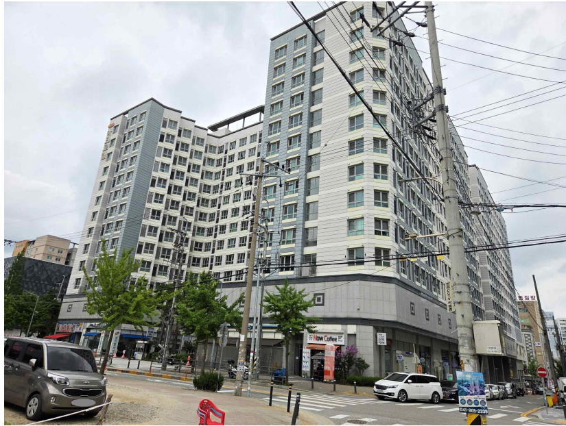
본건 전경(남동측에서 촬영)
