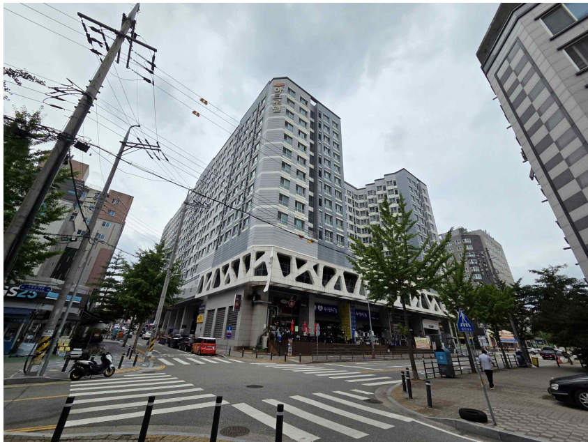
본건 전경(남서측에서 촬영)
