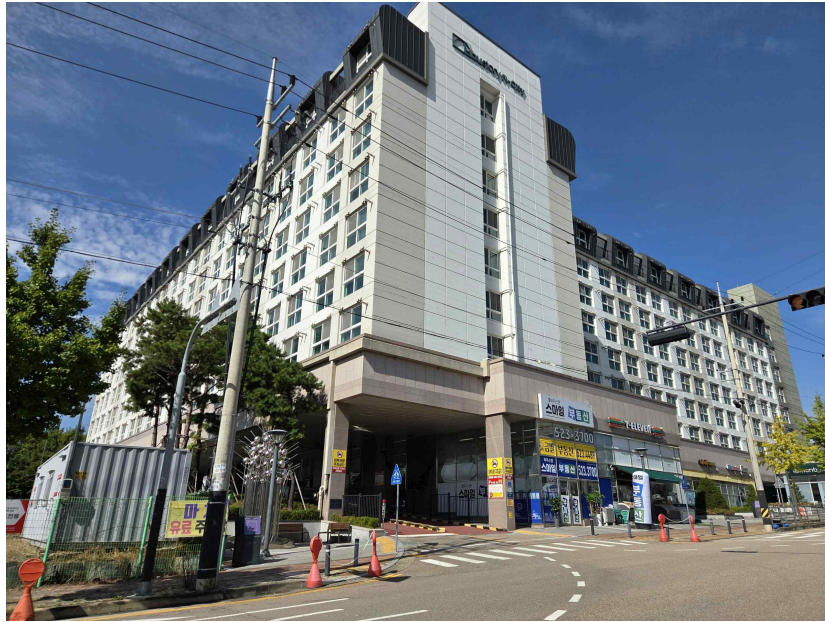
본건 건물 전경(남측에서 촬영)
