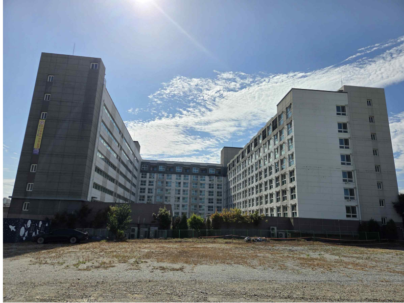
본건 건물 전경(북동측에서 촬영)
