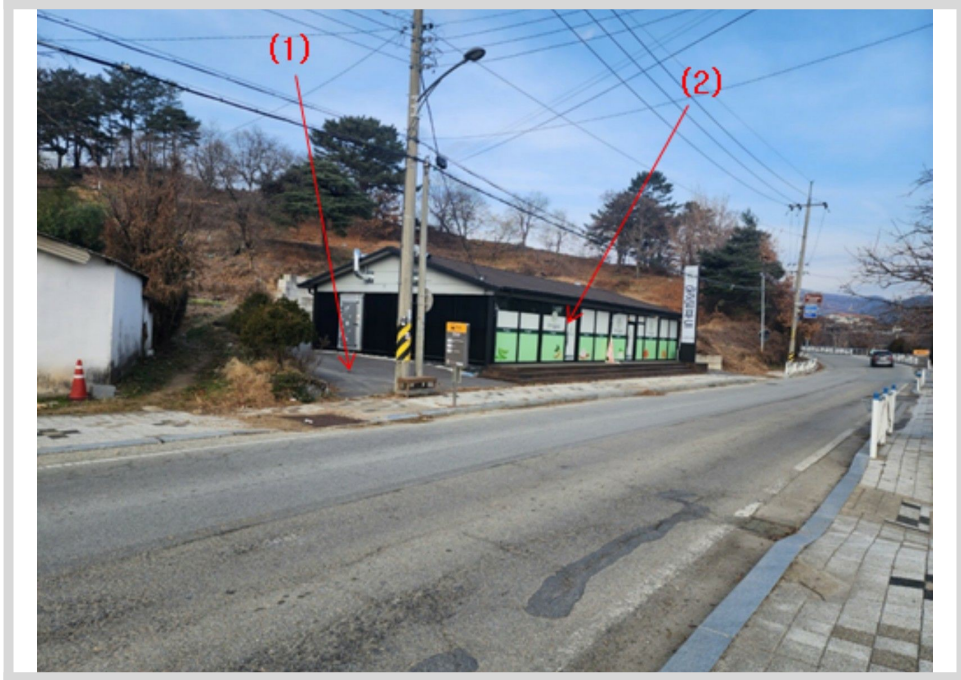
기호(1,2) 전경 - 본건 남동측에서 촬영
