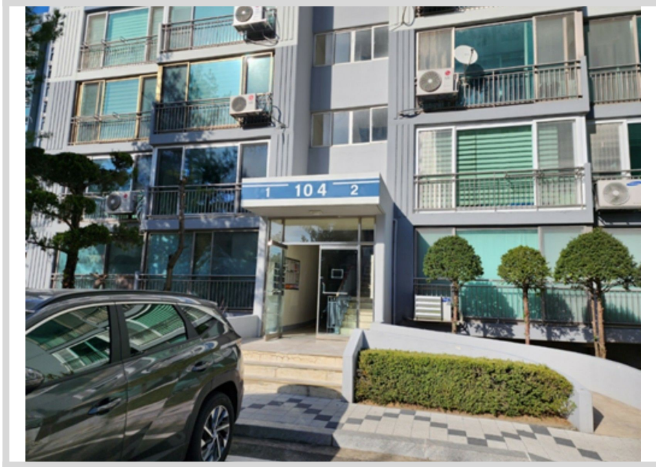
본건 1층 공동 출입문 전경
