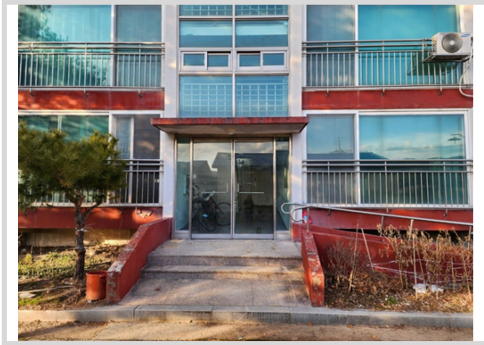
본건 1층 소재 공동 출입문 전경
