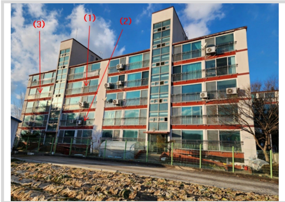
기호(1,2,3) 전경 - 본건 남동측에서 촬영
