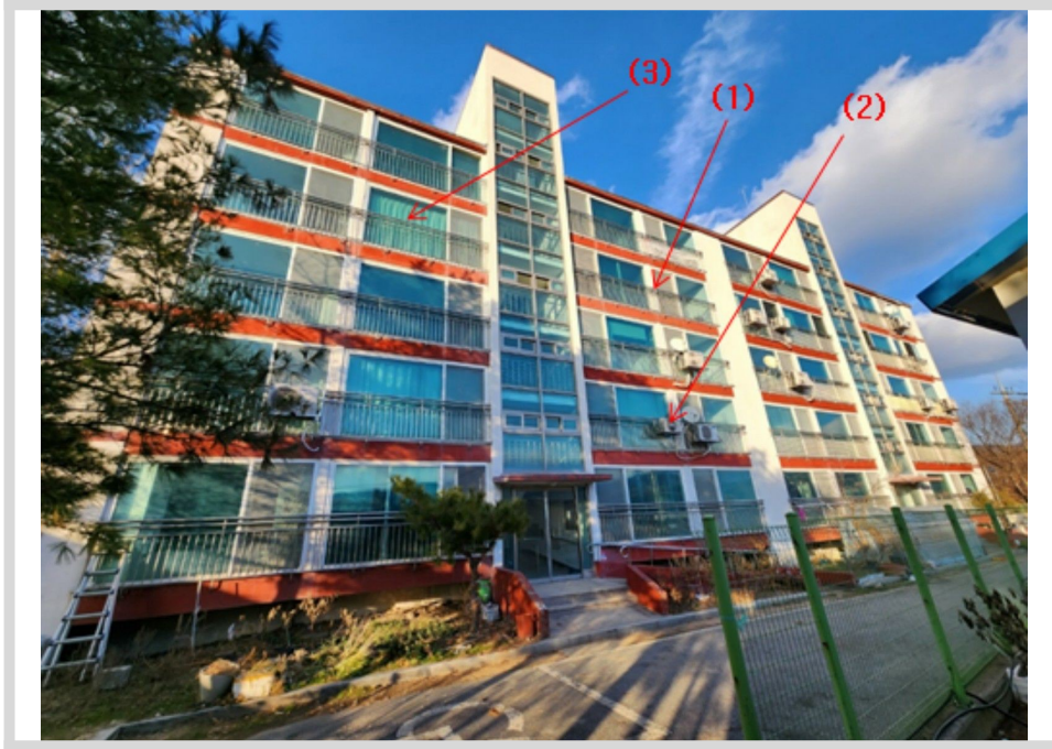
기호(1,2,3) 전경 - 본건 남서측에서 촬영
