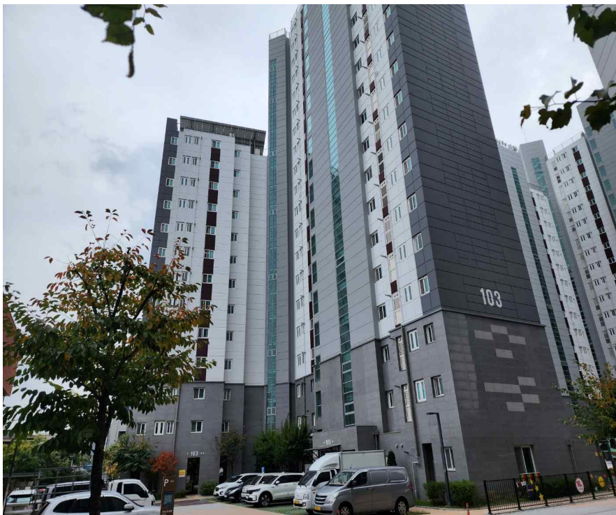
본건동 전경 (동측에서 촬영)
