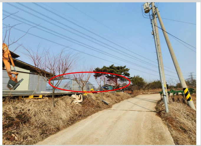
본건 전경(남동측에서 촬영)
