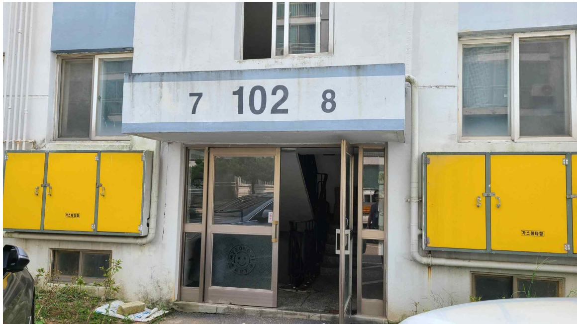
102동 7호 8호 1층 출입구
