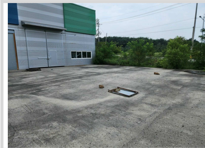
기계기구 지하부분 전경 2
