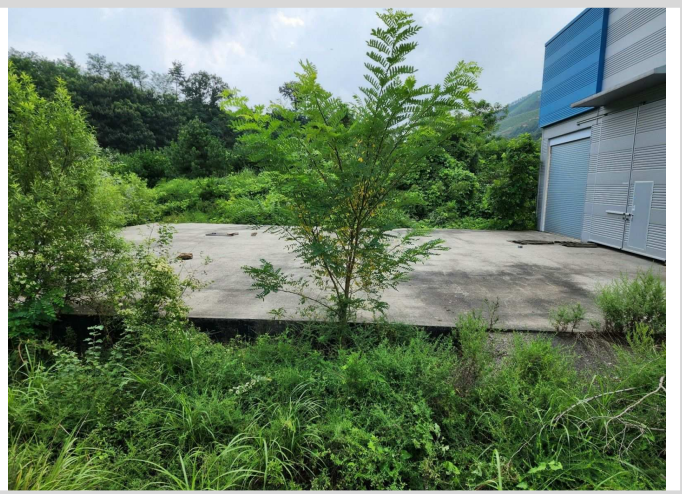
기계기구 지하부분 전경 1
