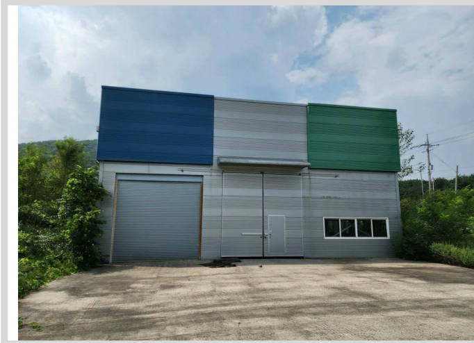
기계기구 (제시외 건물㉠) 전경 2
