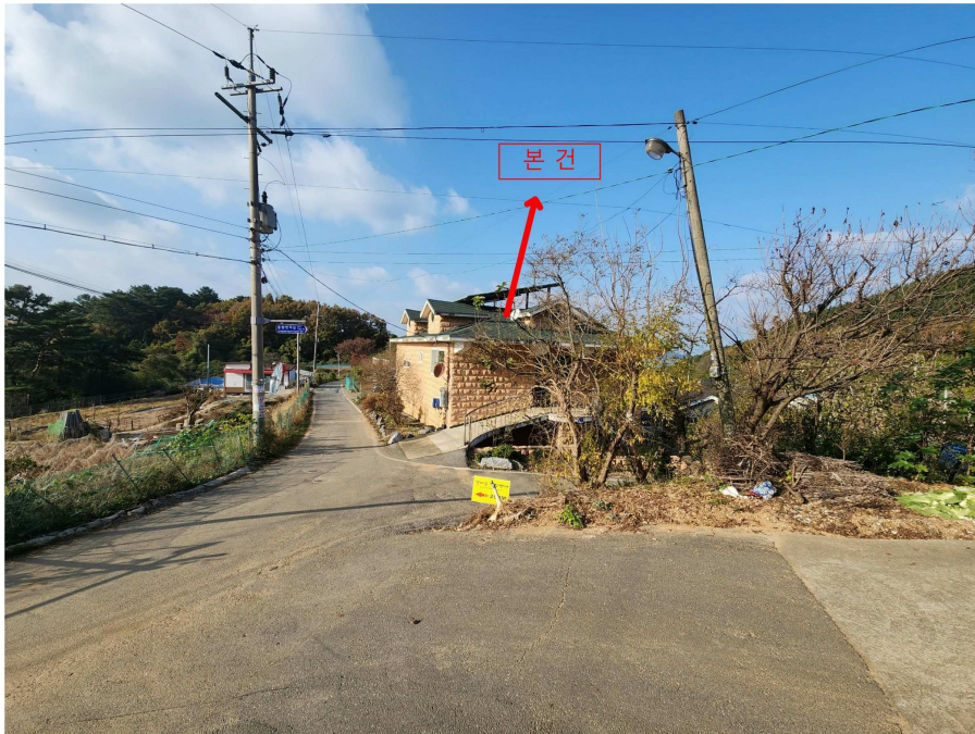
본건 전경(남동측에서 촬영)
