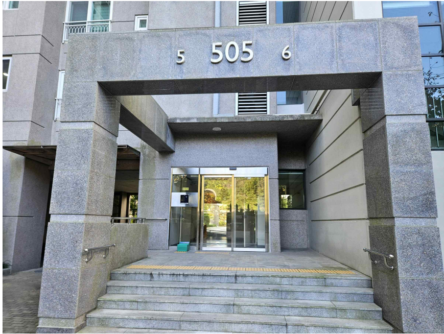
505동 5호 6호 1층 전경
