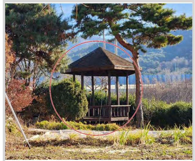
제시외건물 ㄷ) 전경
