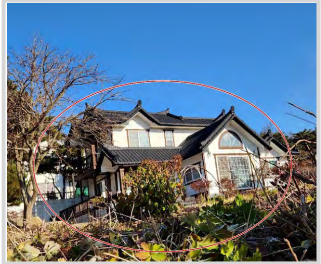
기호 1 건물 전경
