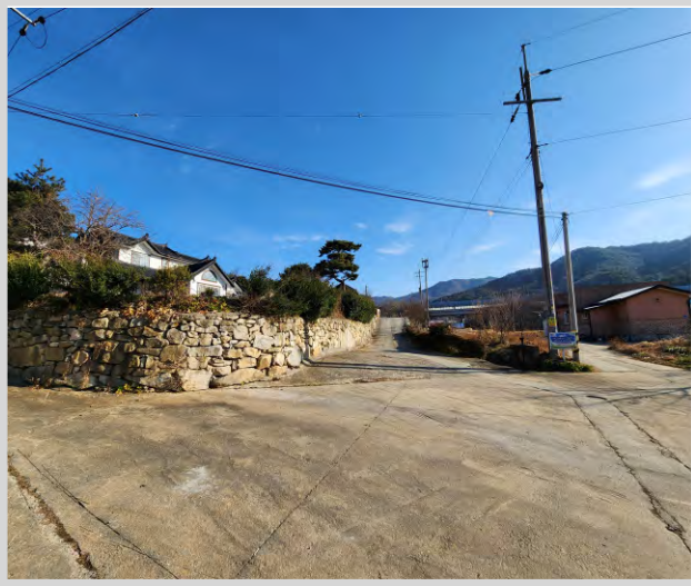
본건 남측 도로 전경
