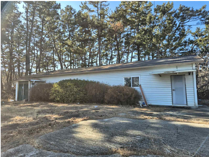
본건 건물 기호 '7' 전경
