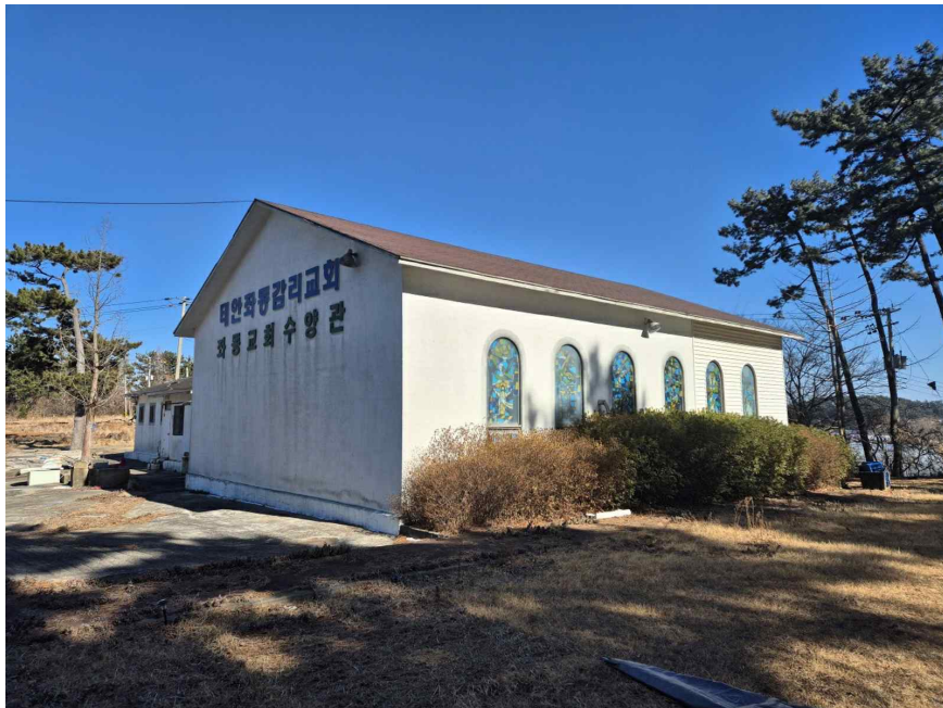
본건 건물 기호 '2' 전경
