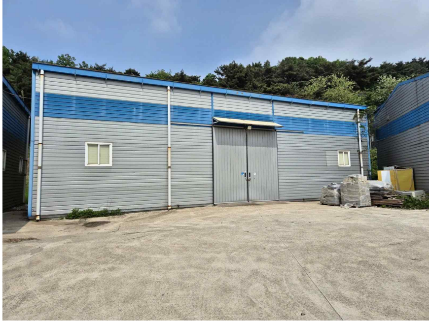
본건 건물 기호 '5' 전경
