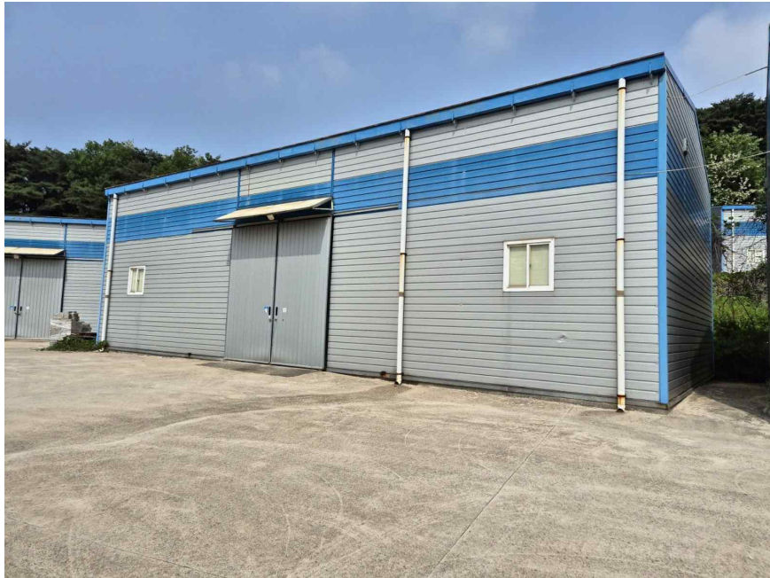
본건 건물 기호 '6' 전경
