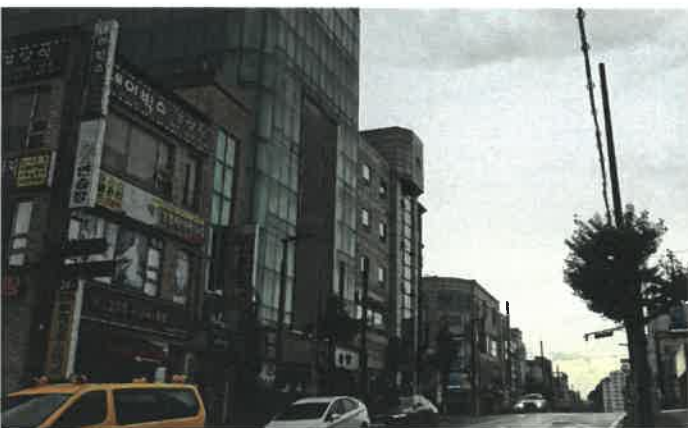
본건 전경(북서측 도로 월편에서 촬영)
