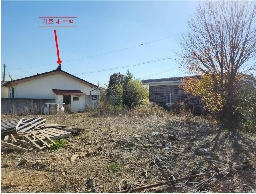
기호 4-주택 전경(서측에서 촬영)
