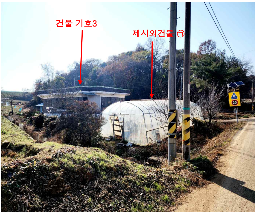
토지 기호1 전경 (북동측에서 촬영)
