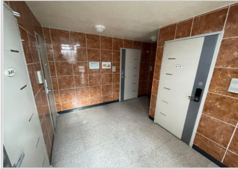
[기호 ① 3층 내부전경]
