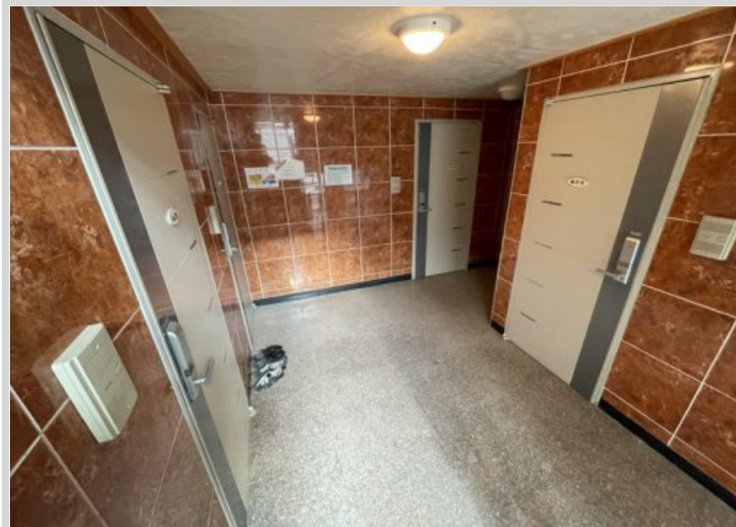
[기호 ① 4층 내부전경]
