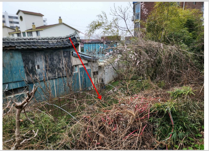
본건 전경(북서측에서 촬영)
