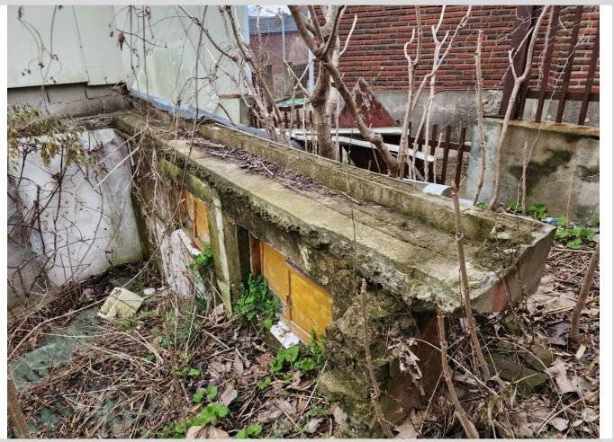
콘크리트 구조물 전경
