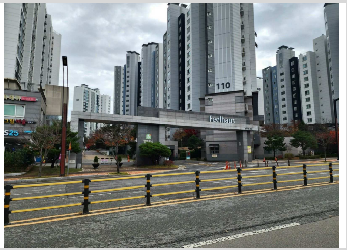
단지 주 출입구 전경
