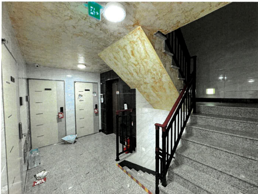
대상물건 일련번호 나) 3층 복도
