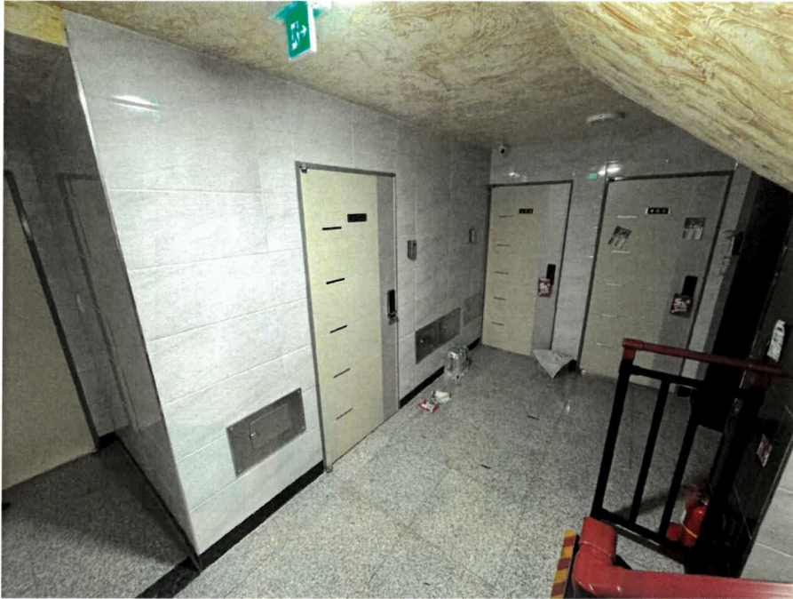
대상물건 일련번호 나) 4층 복도
