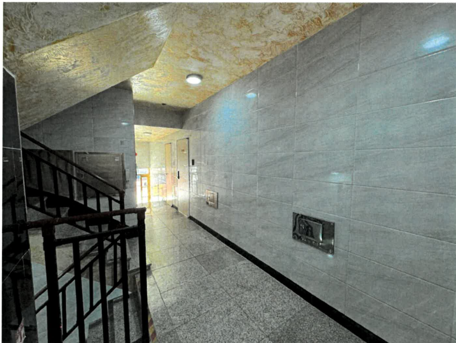
대상물건 일련번호 나) 1층 복도
