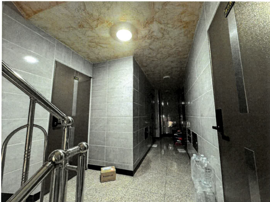
대상물건 일련번호 다) 3층 복도
