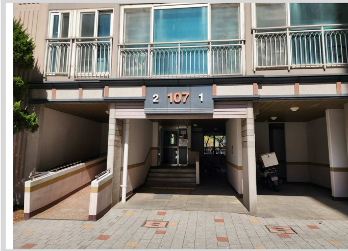
1층 출입구 전경
