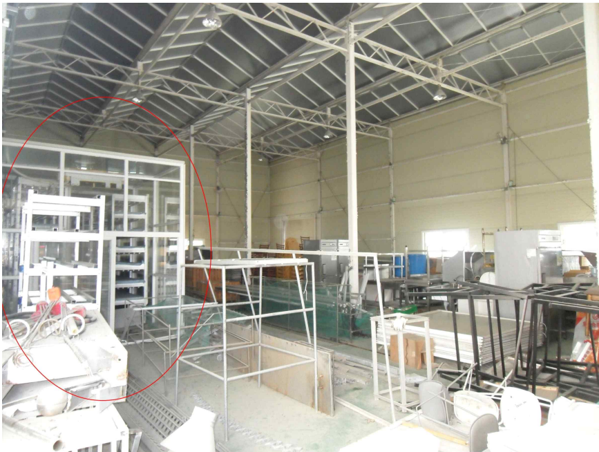
본건 기호 17 내부 및 제시외 ㉡기타(좌측)
