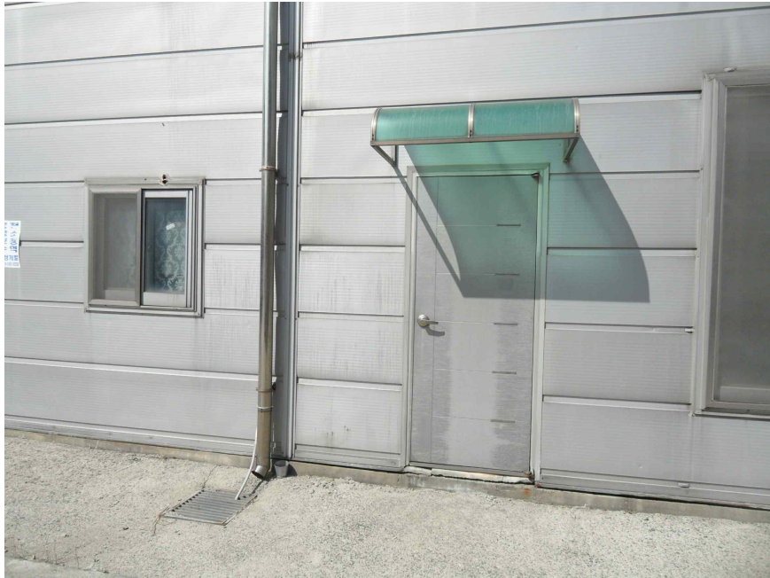
본건 기호 16 1층 출입문
