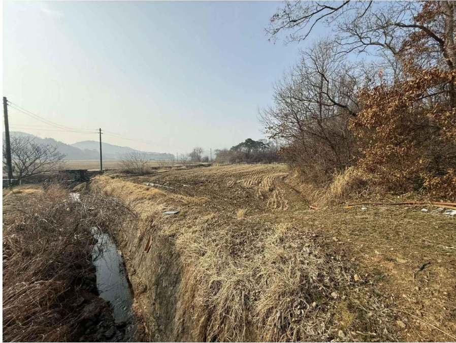
기호(1) 및 주위전경
