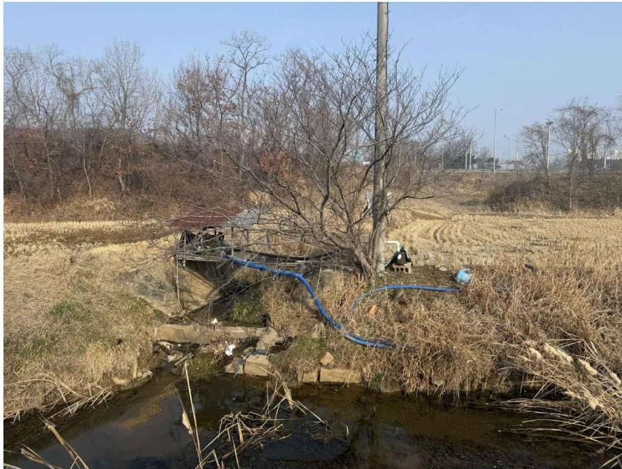
기호(1) 현황 하천부분 및 펌프 등
