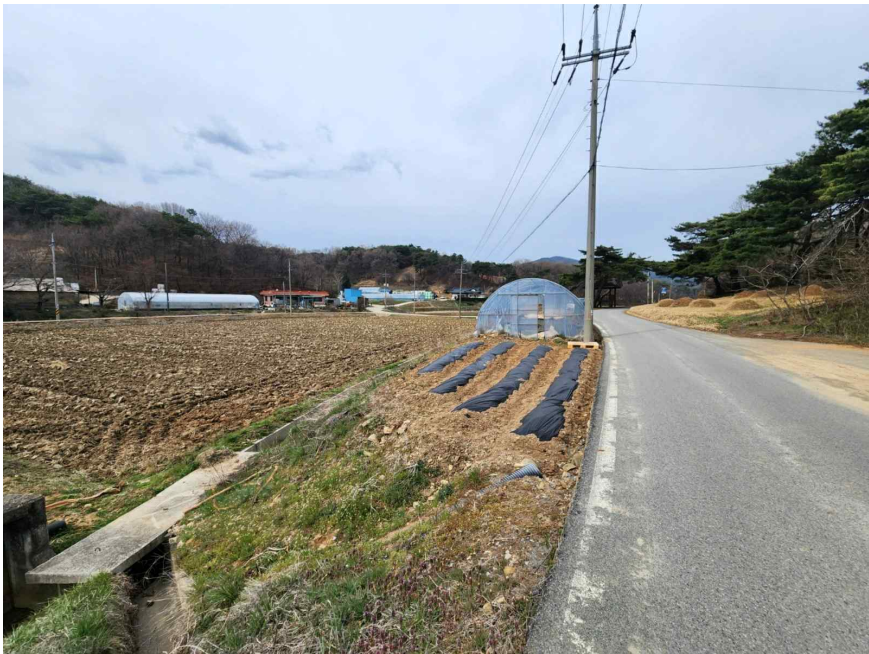
일련번호 1), 3) 주변환경 - 남동측에서 촬영
