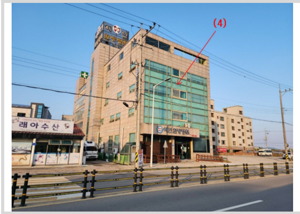
기호(4) 전경 - 본건 남서측에서 촬영
