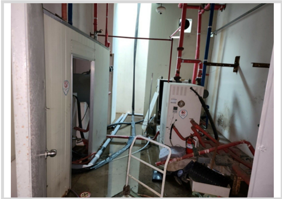
기호(4)지하1층 내부 전경
