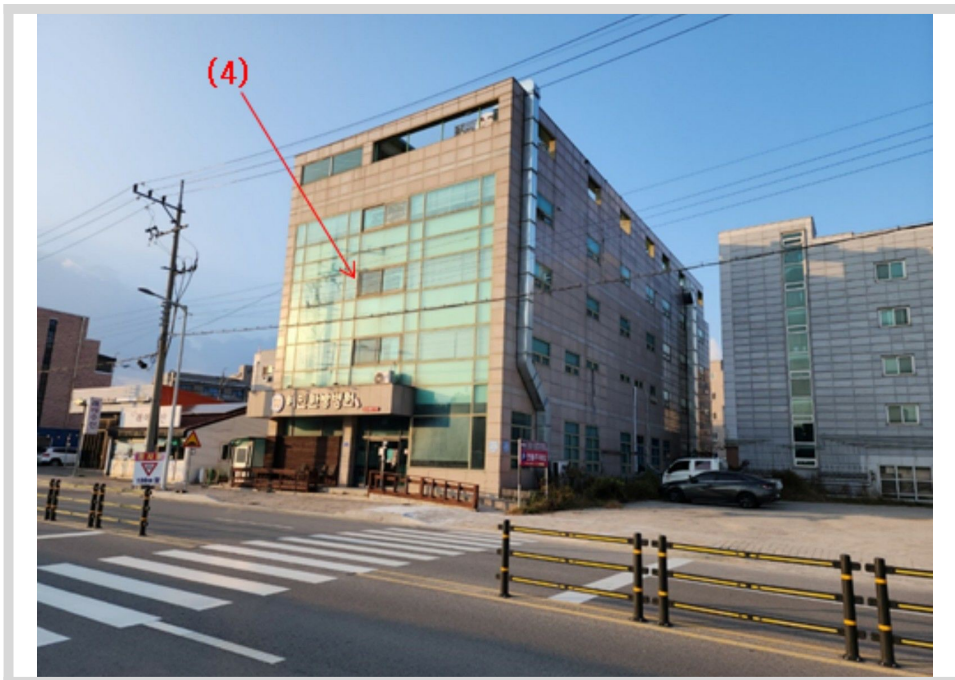
기호(4) 전경 - 본건 남동측에서 촬영
