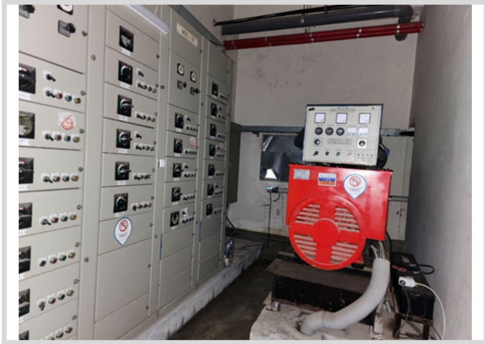
기호(4)지하1층 내부 전경
