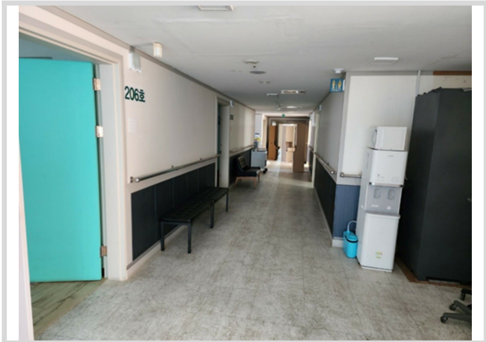
기호(4)2층 내부 전경
