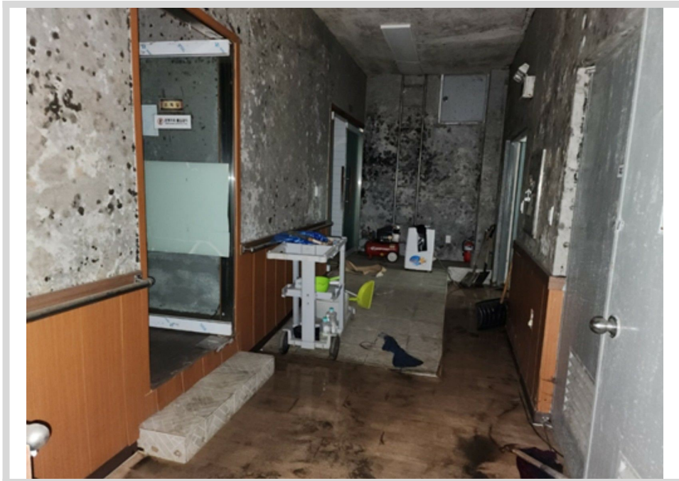
기호(4)지하1층 내부 전경
