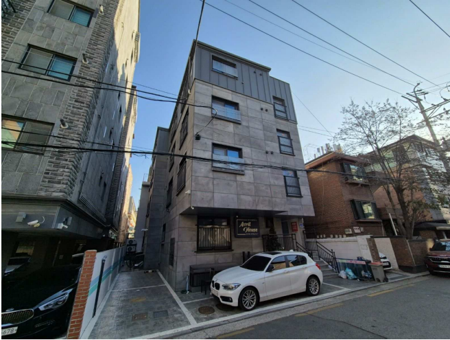
본건 건물 전면부 전경
