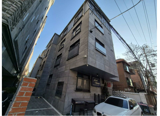
본건 건물 측면부(북서측) 전경
