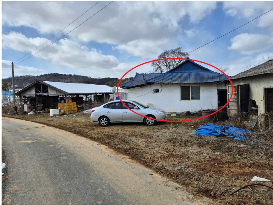
본건 토지 기호 '6' 및 제시외 건물 ㉠ 전경
