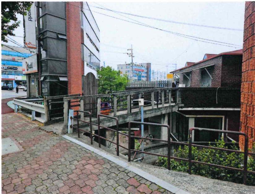
일련번호 2) 동측 도로에서 주택 2층 연결 간이육교
