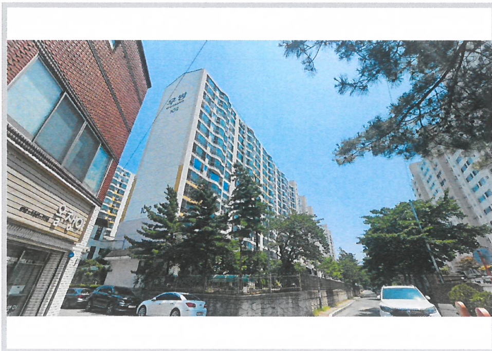
본건 전경 (남서측에서 촬영)
